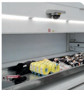
Iluminación LED bahía externa
