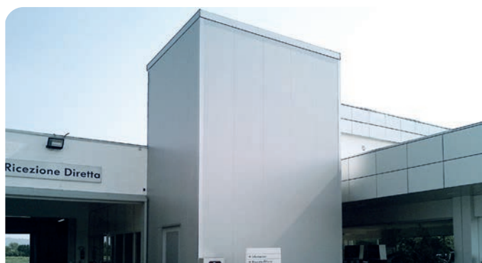
Instalaciones exteriores (Indispensable estructura protectora)
